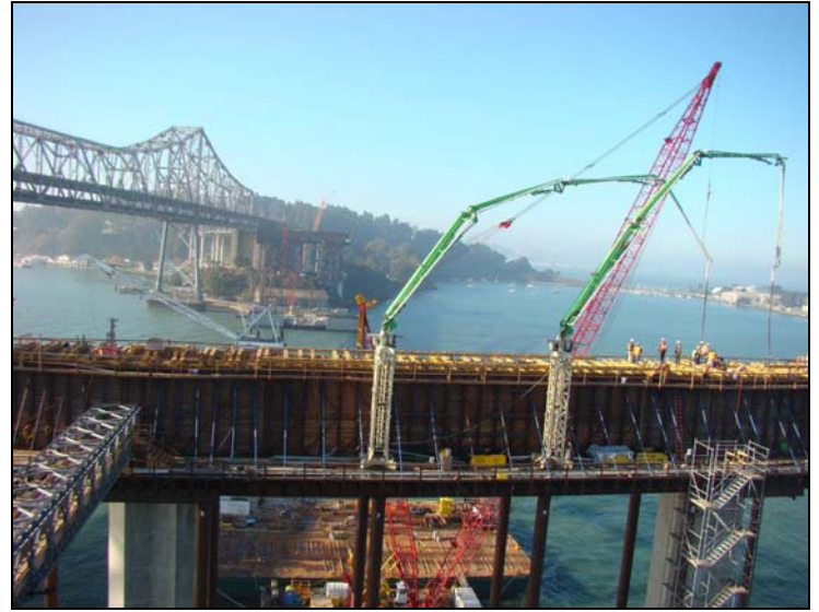
E2 Support Structure Concrete Pour
