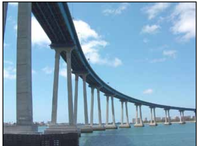
San Diego-Coronado Bridge
